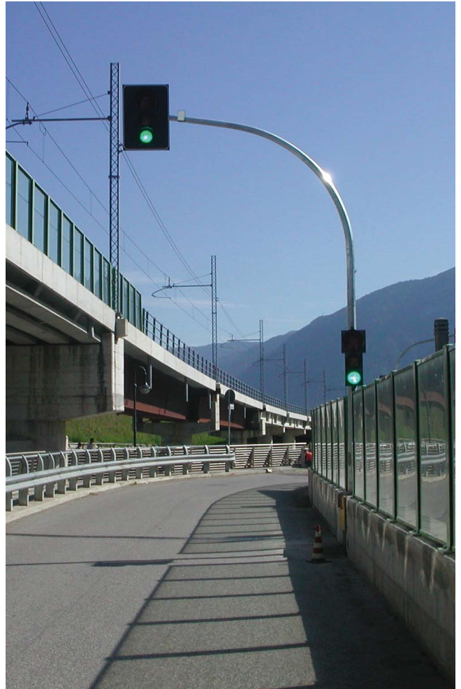
Radar RLV impiegato su impianti semaforici per il controllo della velocità
